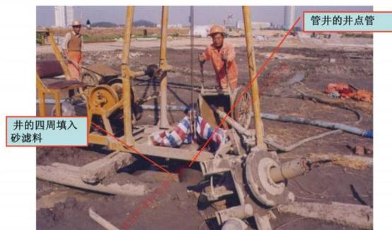
管井井点施工时，先用小型钻机钻孔或水冲成孔，插入井点管后，在管四周填入砂滤料，井内放入潜水泵。
